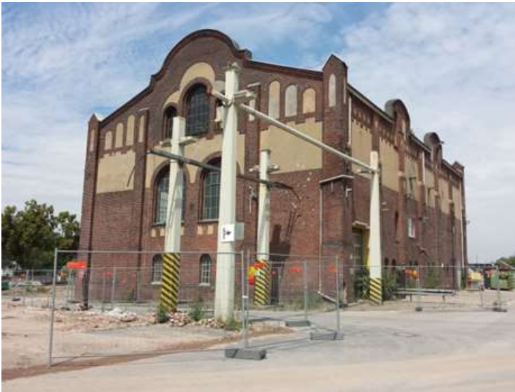
Abb. 2: Außenansicht Quelle: Untere Denkmalbehörde, Stadt Gelsenkirchen, 2014
